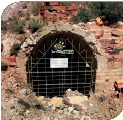
Antigua entrada a la mina de carbón.
